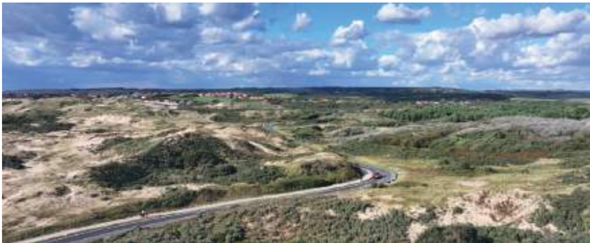
■ Vélomaritime traversant les Dunes de la Slack entre Wimereux et Ambleteuse. © Département du Pas-de-Calais
