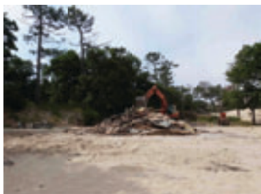
Démolition du bâtiment commercial situé au pied de la Dune du Pilat @SMGDP
